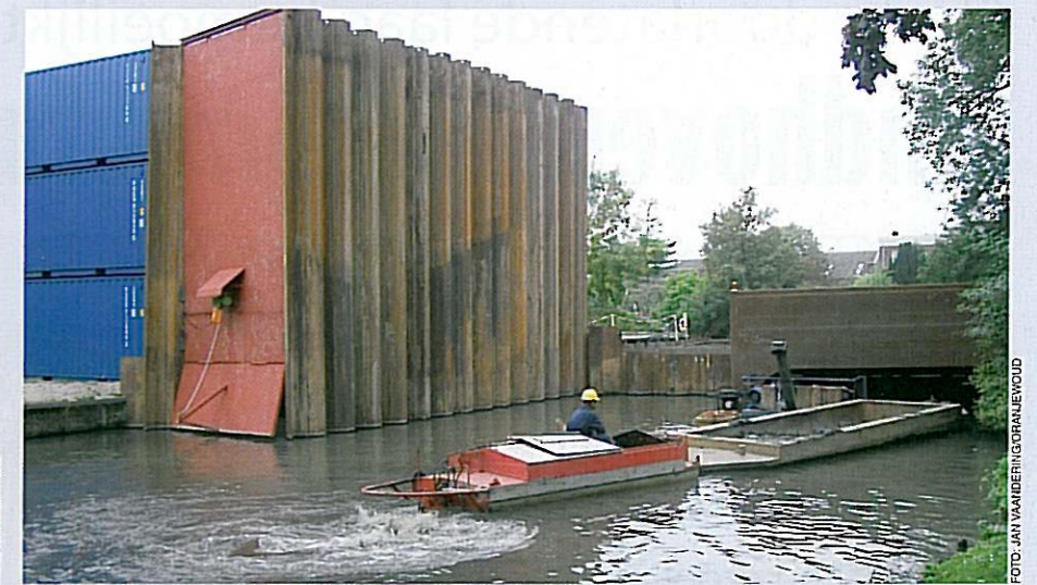
Beunbakken varen via de achterzijde de bombox in en varen via een afsluitbare opening binnen in de scheidingslocatie.
