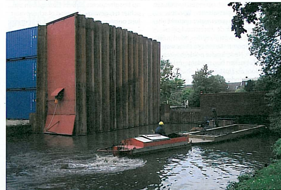
In de BomBox ligt een klein baggervartaug met een cabine die de machinist beschermt tegen eventueel rondvliegende scherven.
