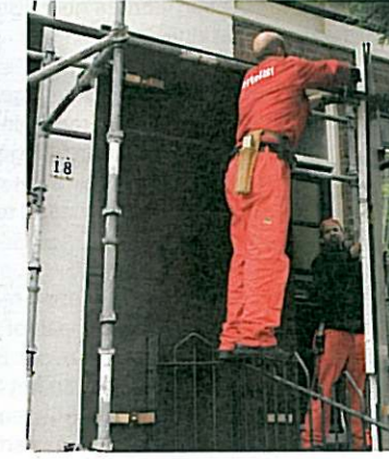
De ramen van omliggende huizen worden beschermd in verband met het explosiegevaar.
